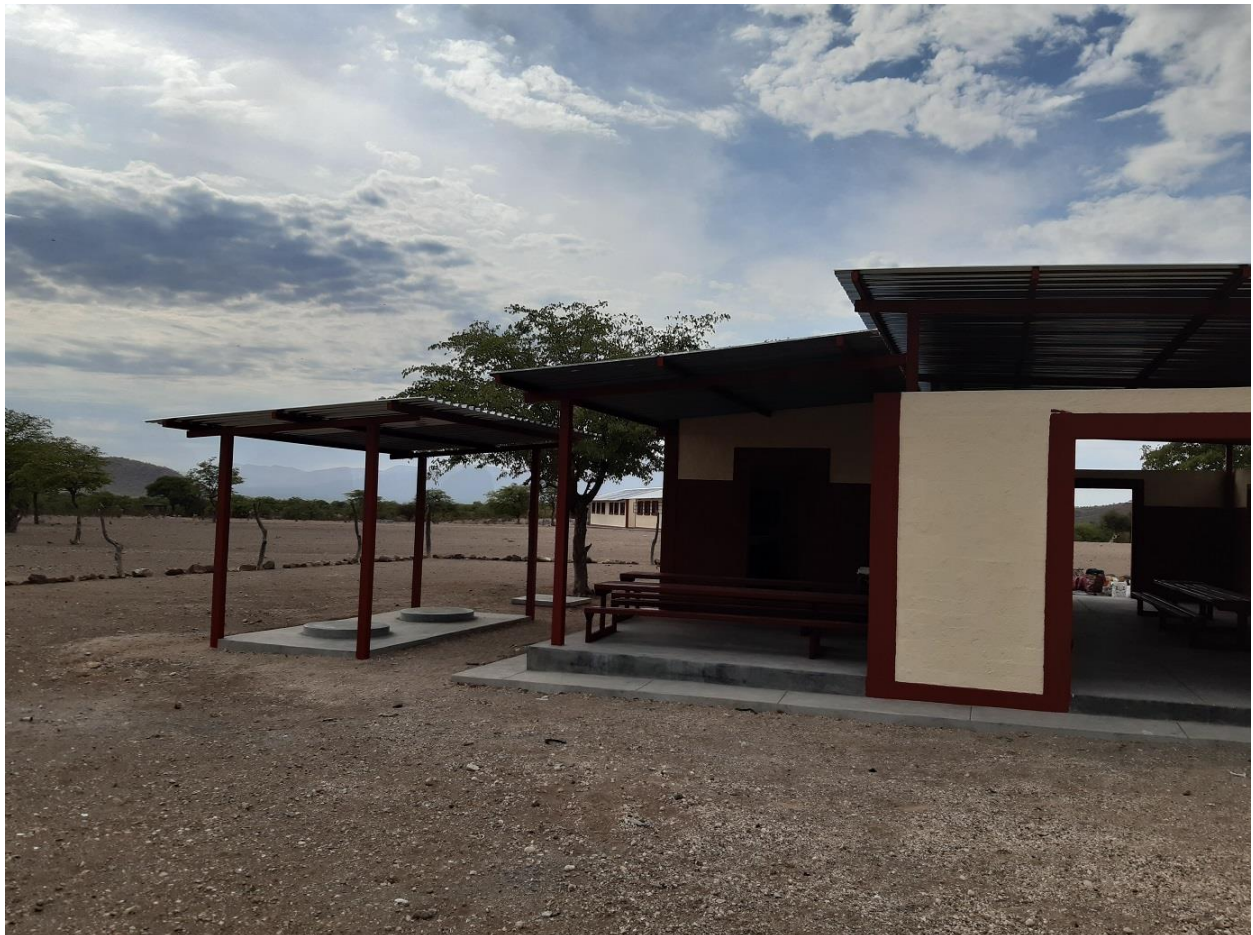
Bildtitel: Kochstelle mit überdachtem Essplatz an der Primarschule in Otjirumbu, Kaokoveld, Namibia
